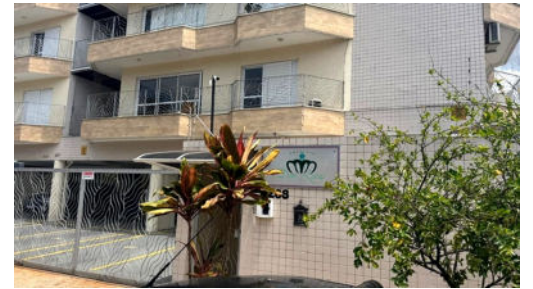
Prédio onde foi encontrado o casal
